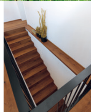
Mafi-Holzboden, Massivholz-Treppenaufdoppelung, Betondecke mit integrierter Leha-Vorhangschiene und Lichtkonzept.
